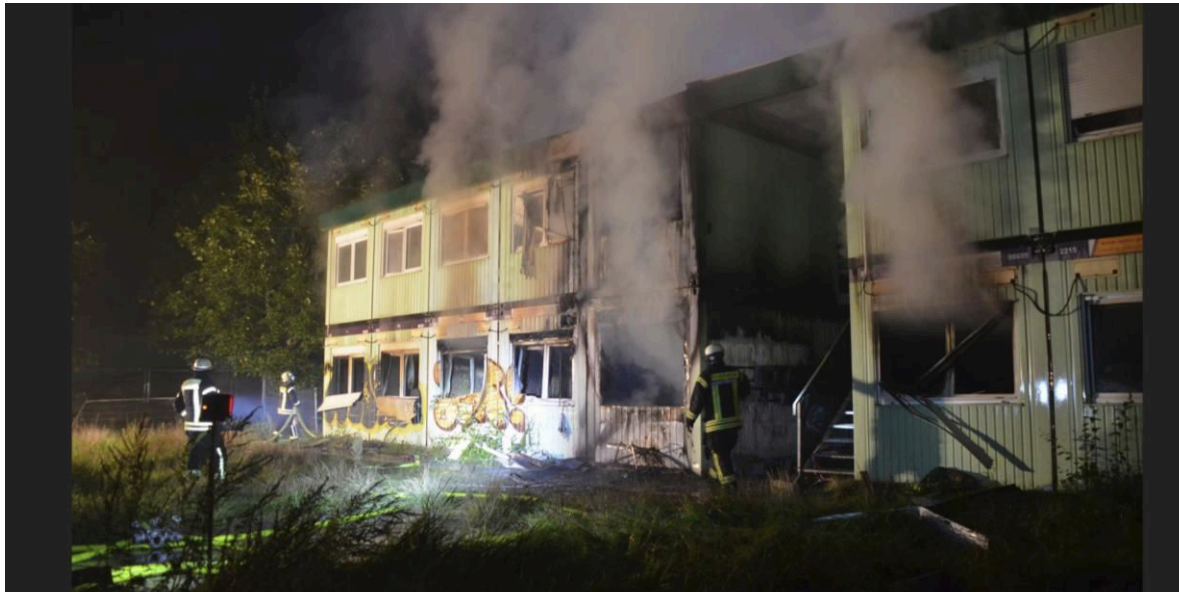
Der Container-Komplex wurde durch den Brand schwer beschädigt.
